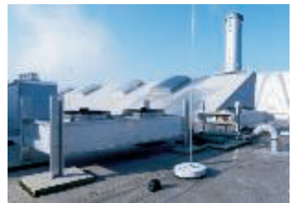
Elszigetelt villámvédelem tetőn található berendezéseknél
