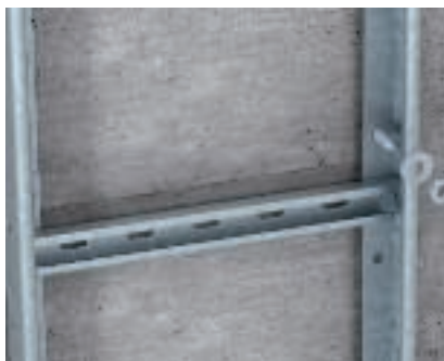
Felszerelés közvetlenül a falra LG és SSL kábelhágcsók rögzítése közvetlenül a falra horgonycsapokkal.
