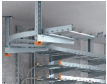
Készre szerelés Készre szerelt kábellétra nyomvonal.
