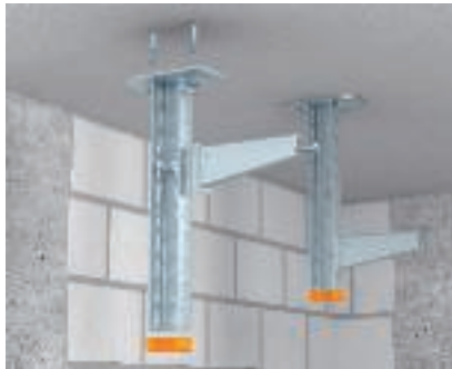
Függesztett oszlopkonzol szerelése, aszimmetrikus elrendezés A függesztett oszlop szerelése oszlopkonzollal. 300 mm tálcaszélességig nem szükséges a DSK közdarabot beépíteni.
