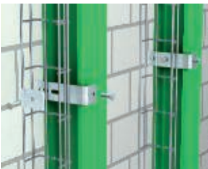
Acélszorító alkalmazása Rácsos kábeltálcák függőleges szerelése acéltartóra, BFK típusú rögzítőelemmel és GKS 50 típusú szorítóval.
