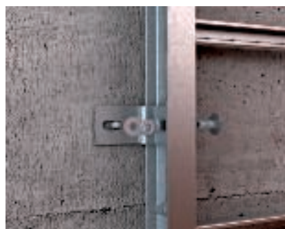
Ipari kivitelű kábelhágcsók rögzítése Az ipari kábelhágcsó a BW 80 55 FT típusú rögzítőszegletekkel rögzíthető a falra.
