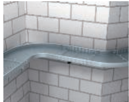
Sarokidom szerelése 400 - 600 mm tálcaszélességig A 400-600 mm széles sarokidomokat a tálcához RLVL összekötőkkel és SSLB toldásponti takarólemezrel kell csatlakoztatni. Az elvárt stabilitás a keresztidom közvetlen környezetében beépített alátámasztásokkal biztosítható.
